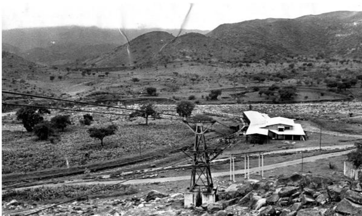
Ο σταθμός στη GHINDA
